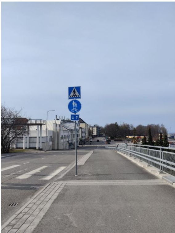
Bild 3 Järnvägsbrons branta nedförsbacke
